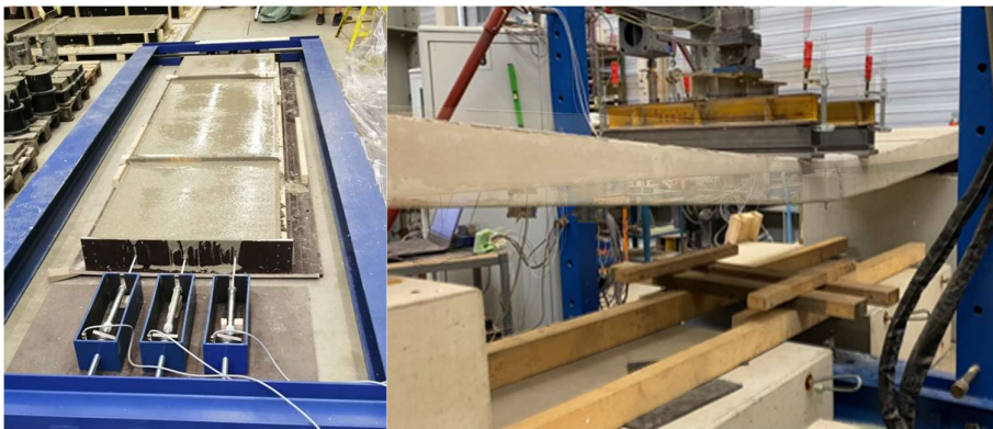
Abbildung 2-6: Herstellung und Prüfung eines Bauteils mit vorgespannten GFK-Spanngliedern
